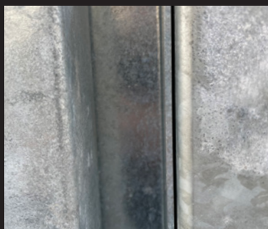
Tous les portails comportent des couvre-joints permettant de s'assurer que l'espace situé entre le poteau et le portail est intégralement clos.
